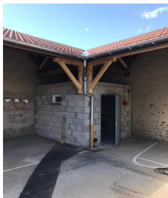
Travaux école maternelle: rénovation de la toiture, changement des menuiseries (fenêtres et volets roulants) Changement de la chaudière de l'école
