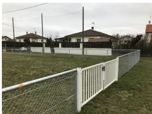
Mise en place des barrières de sécurité autour du Stade Municipal Henri Gatel
