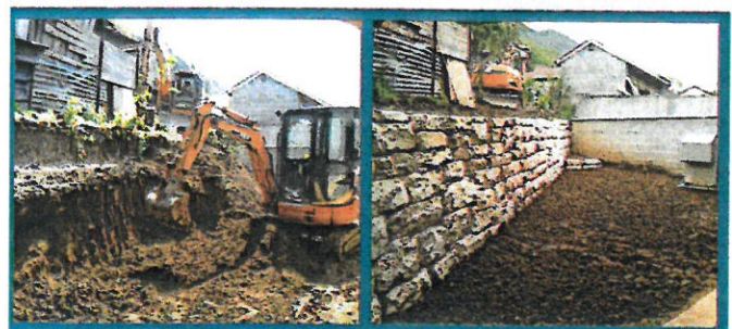
Avant et après enrochement
