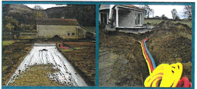
Terrassement et réseaux VRD
